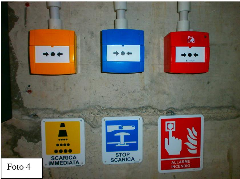
Nel caso sia necessario intervenire manualmente, e **solo per validi motivi**, come ad esempio la presenza di fiamma senza che i sensori l'abbiano rilevata, è possibile farlo premendo il pulsante **GIALLO** (scarica immediata), ovviamente una situazione di questo tipo si può verificare solo se, presenti sul posto, ci si accorge dell'incendio.
