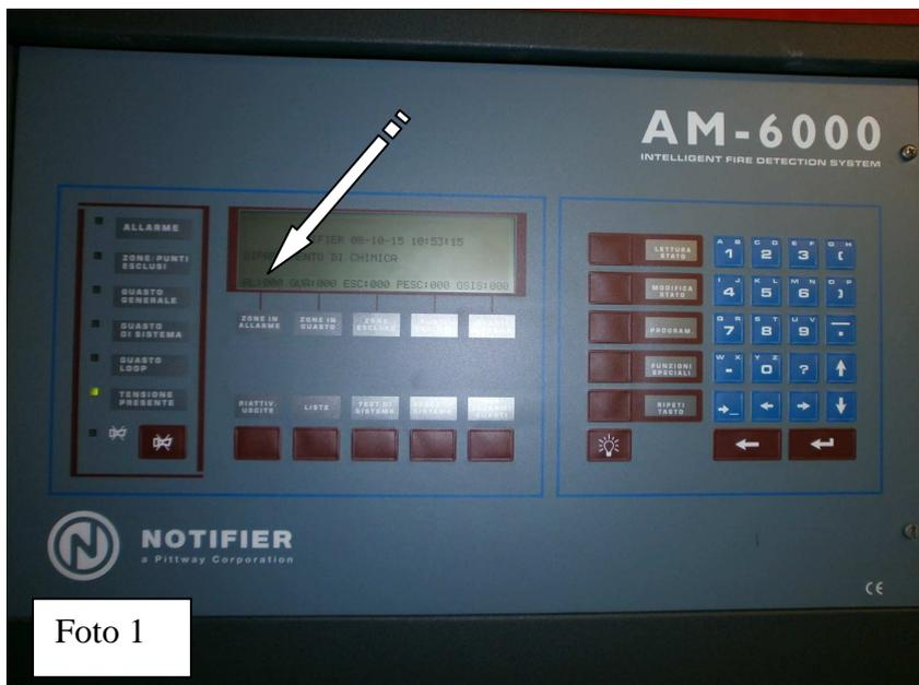
In caso di allarme, nella centralina della portineria, comparirà l'indicazione di quale deposito è in allarme incendio: **T23** deposito sez. Generale - **T24** deposito sez. Organica - **T26** deposito sez. Industriale.
